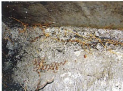
緑化部分のスラブ表面 [写真2]
